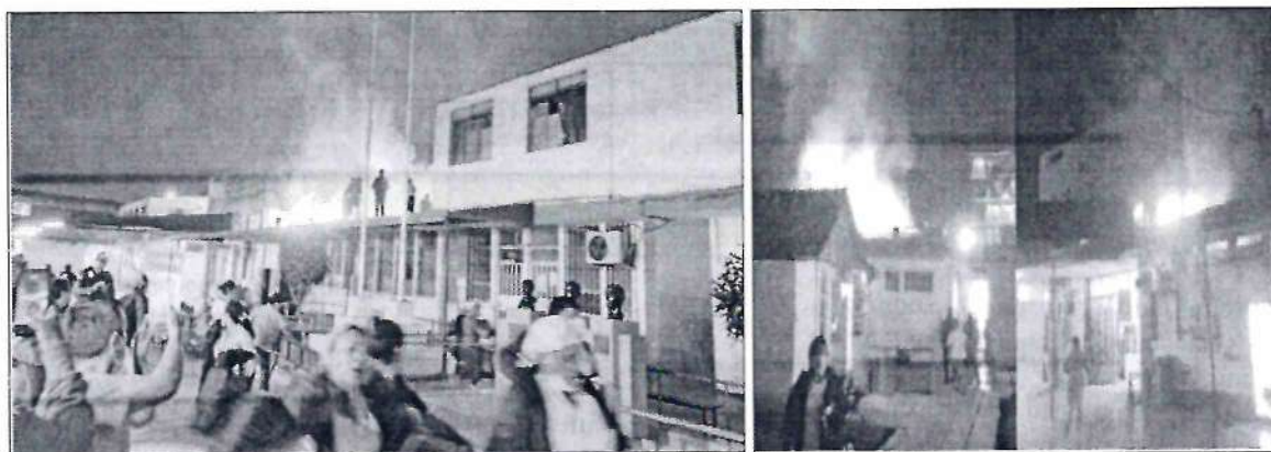
Un incendio de grandes proporciones se registró el 25 de setiembre 2023 en el Hospital Carlos Lanfranco La Hoz, en el distrito de Puente Piedra; el siniestro inició alrededor de las 6:35 p. m. y fue controlado al promediar las 8:00 p. m. Empezó en el área de Archivo de Historias Clínicas Antiguas, pero se extendió a un ambiente administrativo y a la parte superior de consulta externa.
